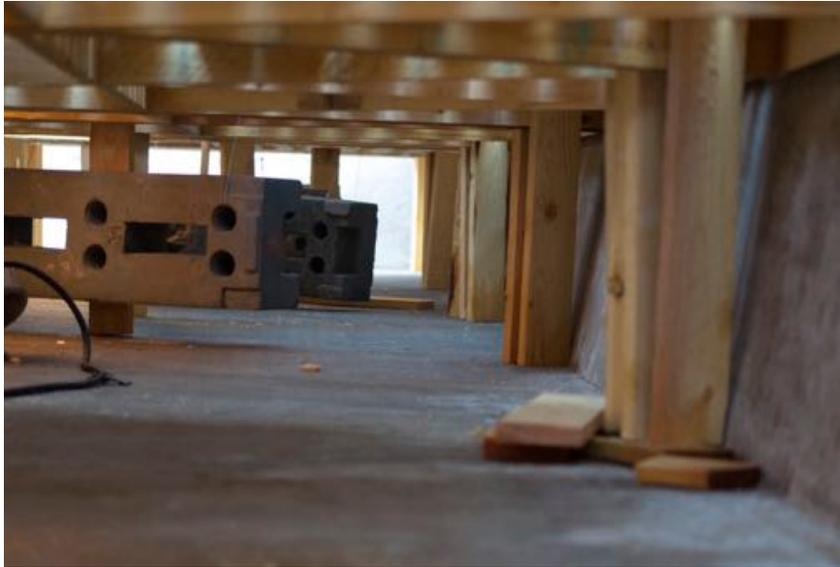
Damit die Fontänen später aus der Fläche heraus kommen, wurden Aussparungen in die Plattform gebohrt. Die hierfür benötigte Größe wurde zuvor im Experiment ermittelt. Zur Verhinderung des Aufschwimmens der Holzkonstruktion bei gefülltem Becken dienten Betonbauzaunfüße zur Beschwerung. Am Rand wurde eine Leiste unter der Brunnenkante angepasst, die die Plattform abschließt und gleichzeitig unten hält, sodass die Module in einer Ebene bleiben.
